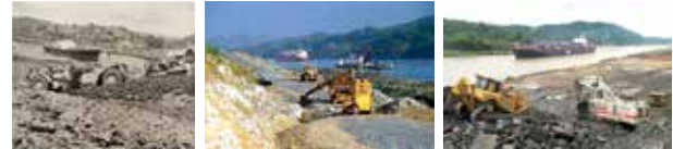
Canal de Panamá - Ampliación de Corte Culebra
